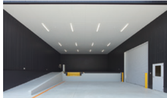
コンテナヤード(ドッグレベラー付)
