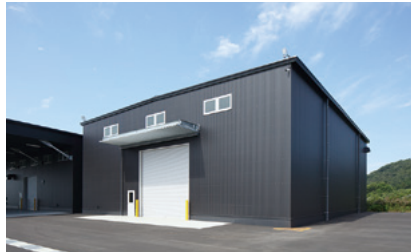
天井クレーン付倉庫
